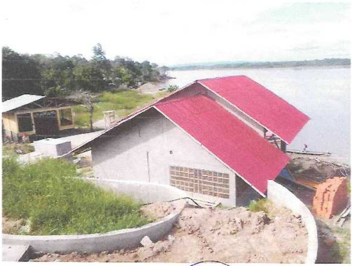
EN LA FOTO SE APRECIA EL TECHADO DE LA PARTE ADMINISTRATIVA Y LA COLOCACION DE VENTANALES
