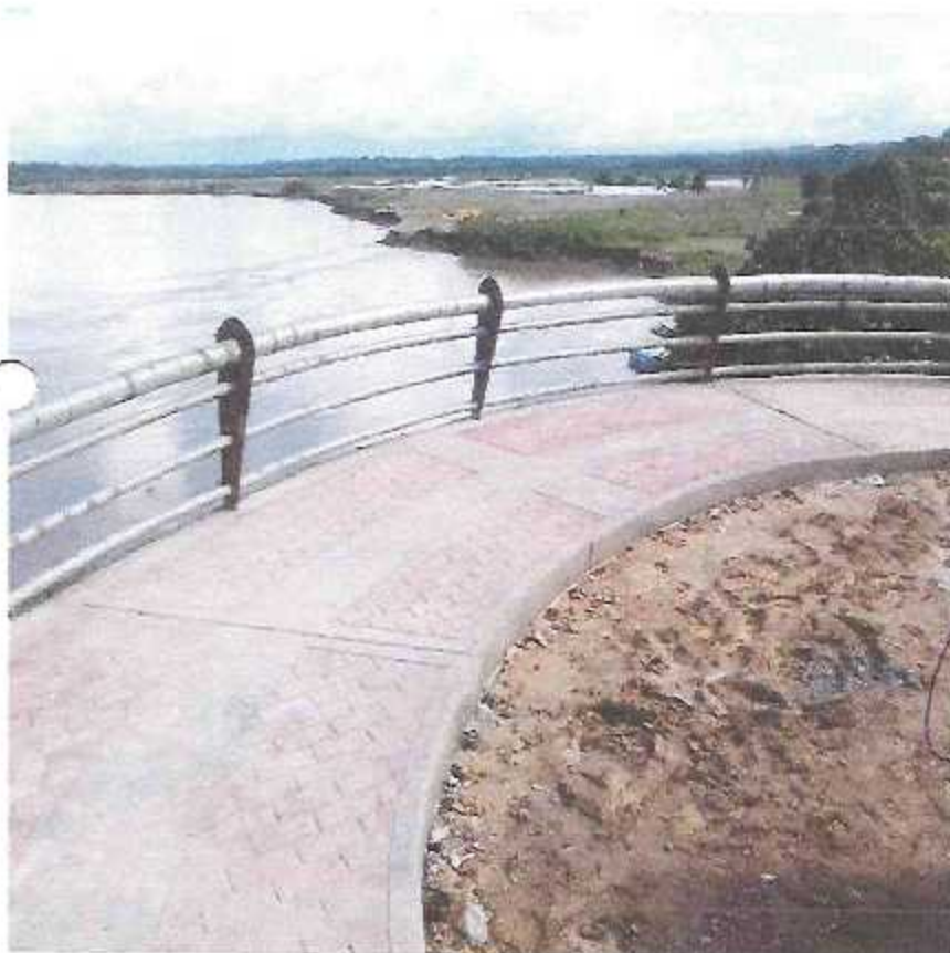
EN LA IMAGEN SE VE LAS BARANDAS EN EL MIRADOR
