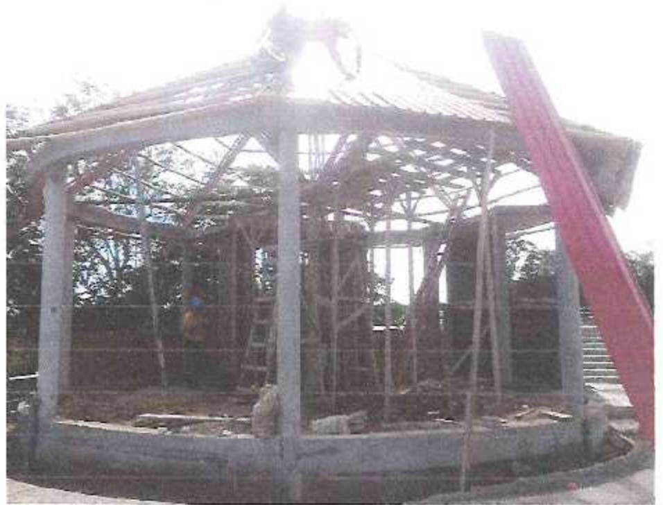
EN LA IMAGEN SE VE EL TECHADO DE LA CLORIETA
